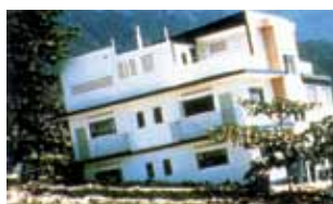
▲ Fig. 50 Clădire avariată după cutremur
