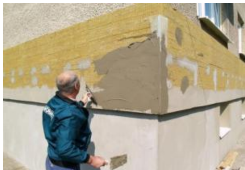
Izolare cu vată minerală bazaltică
