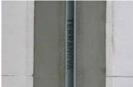
Profil de rost , montare .
