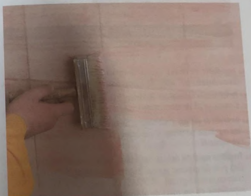
Aplicarea amorsei pe bază de cuarț „BETOHGPUHT” (faianță pe faianță)
