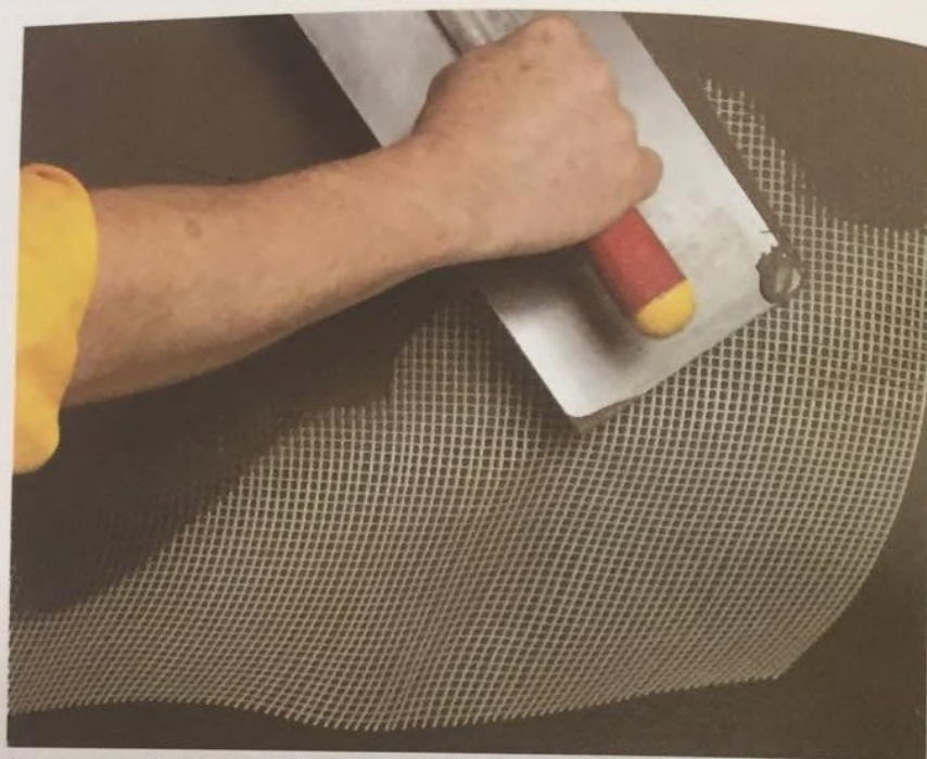
Armarea suprafețelor cu plasă din fibră de sticlă cu adeziv „BAZALT” și „CLASS POLISTIROL”
