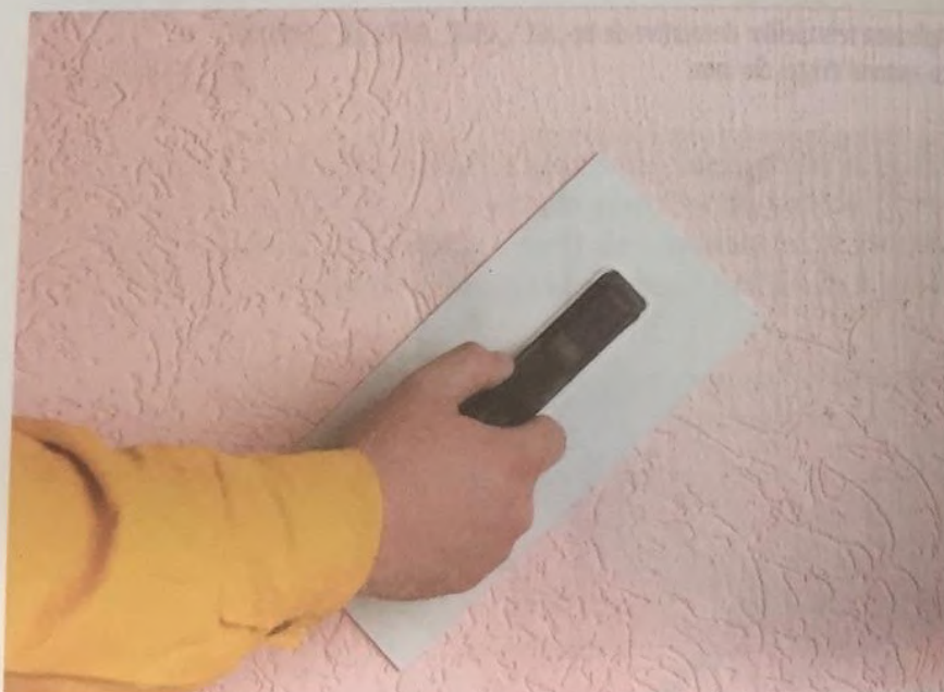
Structurarea suprafețelor tencuite decorativ cu plaster de marmură tip „NIC”, „TINA”, „BARAȘEC”, „COROED” cu ajutorul driștei din masă plastică
