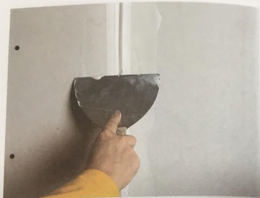
Scufundarea (încercarea) benzii din hârtie perforată în glet „Eurofin”
