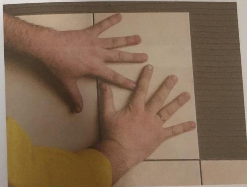
Placarea suprafețelor cu plăci din faianță
