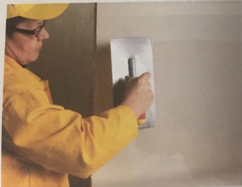
Aplicarea gleturilor pe suprafețele „B-202”, „Finis”, „Meșterul Manole” și „B-62”
