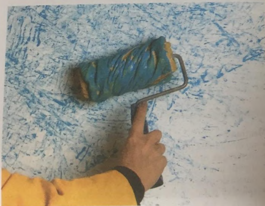
Structurarea suprafețelor vopsite cu ajutorul ruloului
