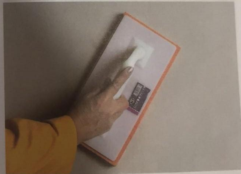
Drișcuirea suprafeței cu drișcă din burete
