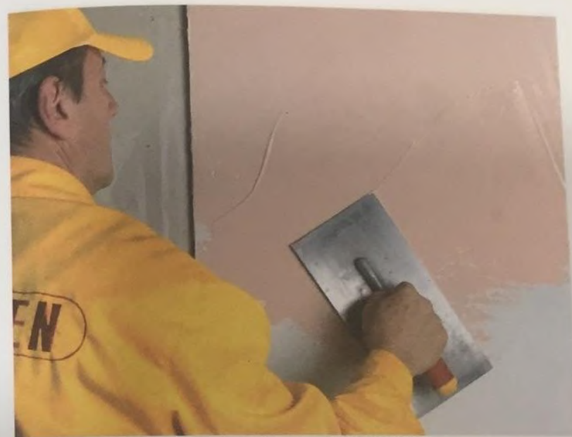
Aplicarea vopselei hidroizolante decorative de tip „FLEKSODEKOR”
