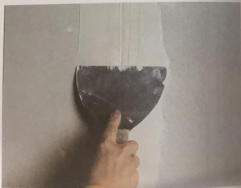
Gletuirea rosturilor la suprafețele din ghips-carton cu gleturi
