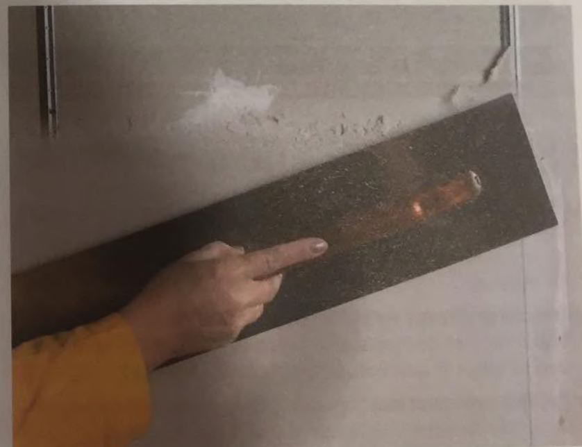
Netezire finală cu ajutorul glatierei din inox
