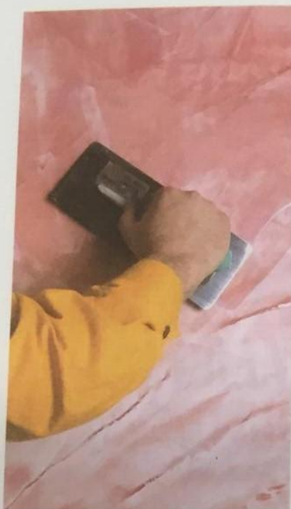
Aplicarea stratului de protecție din ceară pe glet decorativ
