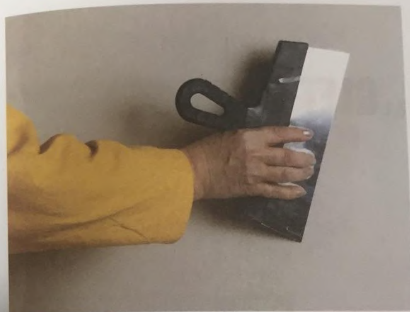
Finisarea suprafețelor din ghips-carton cu șpaclul
