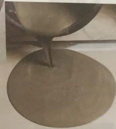
Turnarea (aplicarea) materialelor autonivelante de tip „NIVELIR”
