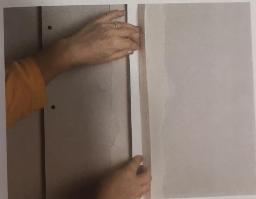
Armarea rosturilor din ghips-carton cu bandă din hârtie perforată
