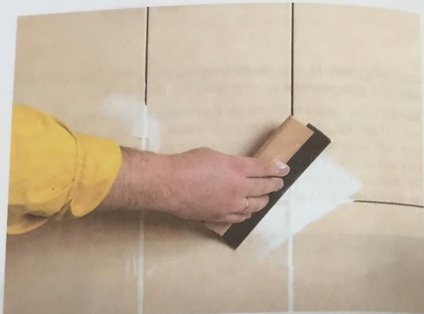
Chituirea rosturilor cu „FUGA”
