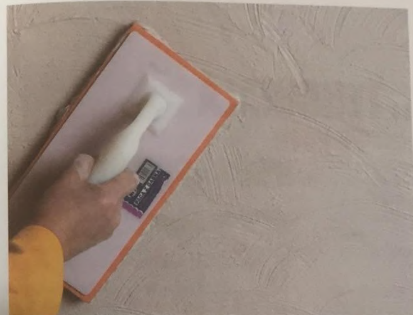
Drișuirea suprafețelor cu drișcă din burete
