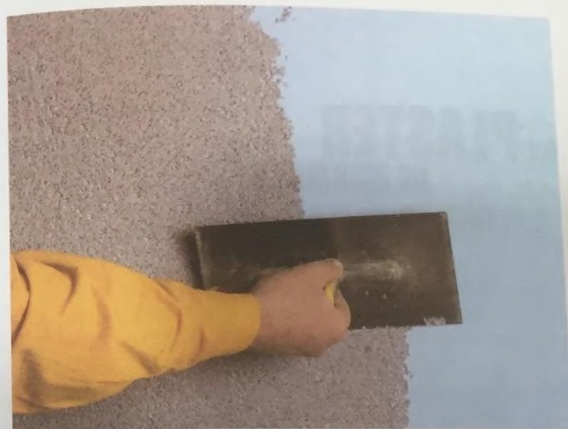
Aplicarea tencuielii decorative plaster de marmură cu drișca din inox
