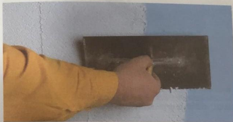
Aplicarea tencuielilor decorative de tip „NIC”, „TINA”, „BARAȘEC”, „COROED” cu ajutorul driștei din inox
