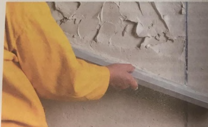
Nivelarea preventivă a mortarelor cu ajutorul dreptarului
