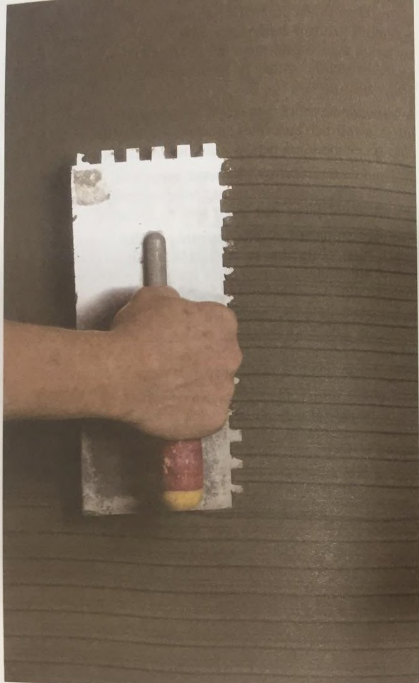
Aplicarea adezivilor pe suprafață pentru încheierea plăcilor din polistiren sau vată minerală
