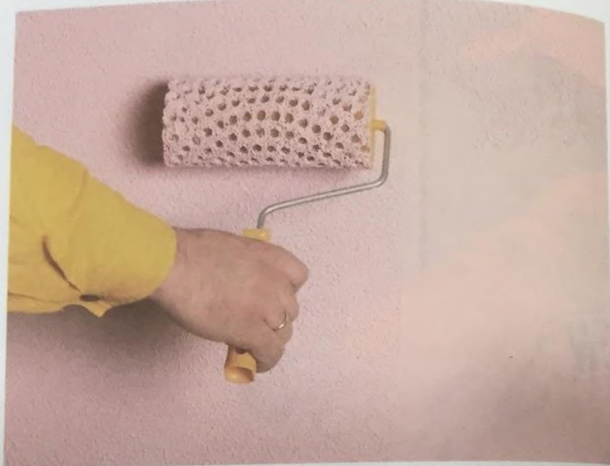
Structurarea cu ruloul a vopselei hidroizolante decorative de tip „FLEKSODEKOR”
