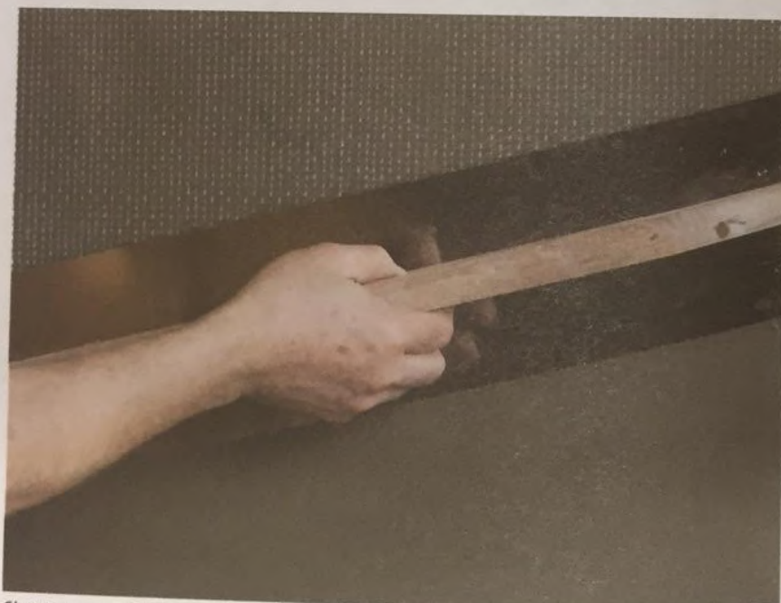
Gletuirea suprafețelor cu adeziv „BAZALT” și „CLASS POLISTIROL”
