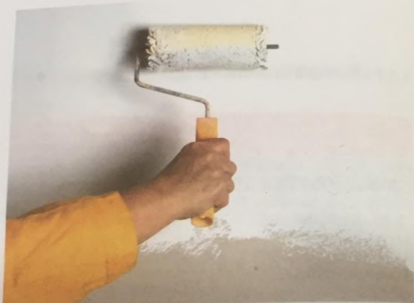
Aplicarea vopselei lavabile pe suprafață cu ajutorul ruloului
