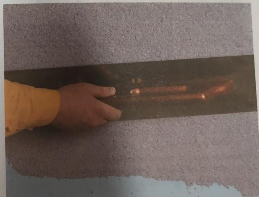
Netezirea tencuielii decorative plaster de marmură cu glatiera mare din inox
