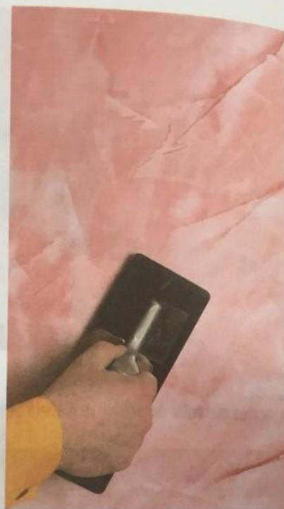
Glenuirea stratului de protecție din ceară pe glet decorativ
