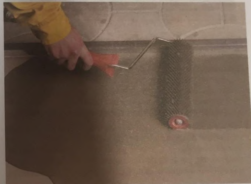
Prelucrarea materialelor autonivelante de tip „NIVELIR” cu ajutorul ruloului cu ace
