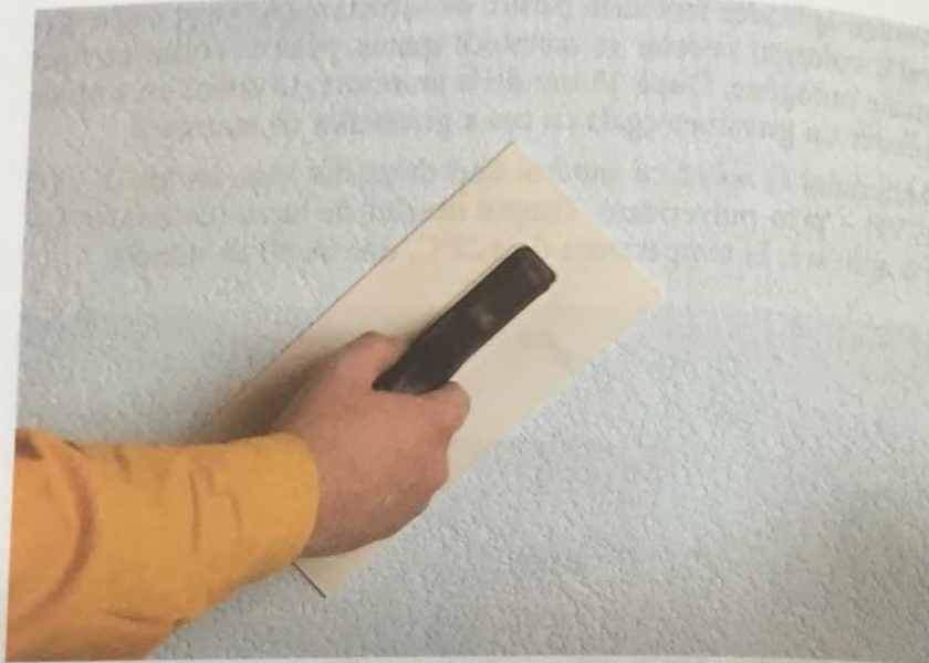
Structurarea suprafețelor tencuite decorativ cu plaster de marmură de tip „NIC”, „TINA”, „BARAȘEC”, „COROED” cu ajutorul driștei din masă plastică
