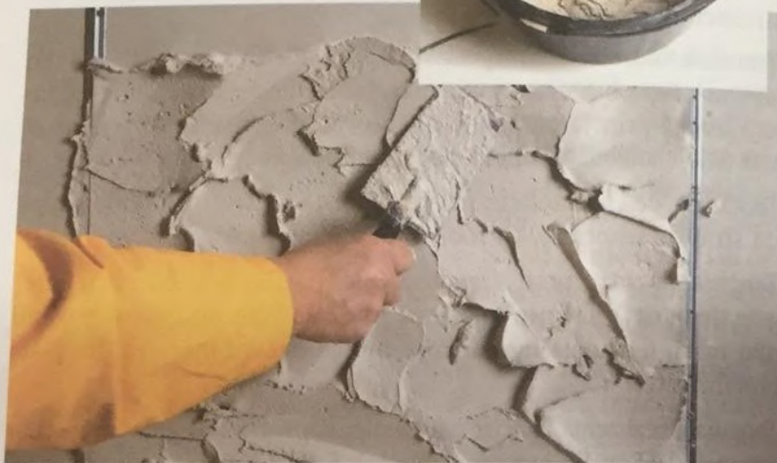
Aplicarea mortarelor pe suprafață
