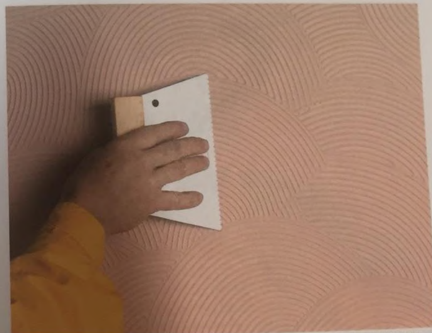
Structurarea cu șpaclu cu dinți a vopselei hidroizolante decorative de tip „FLEKSODEKOR”
