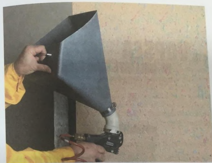
Aplicarea mecanizată a vopselei decorative de tip „RELIEF”.
