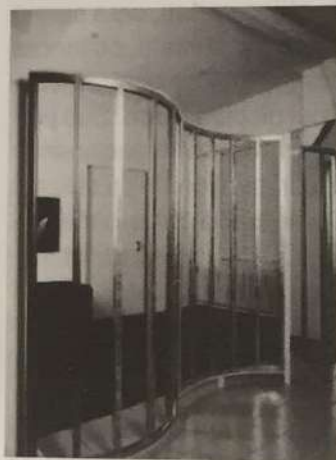
Fig. 11.1. Suprafețele curbilunii ale construcțiilor: carcasă metalică curbată a peretelui de compartimentare din plăci de ghips-carton
