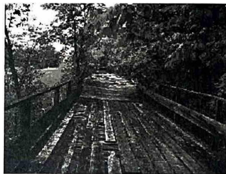
Fig.14 Pod din lemn
