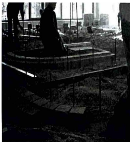
Fig. 21 Borduri din beton
