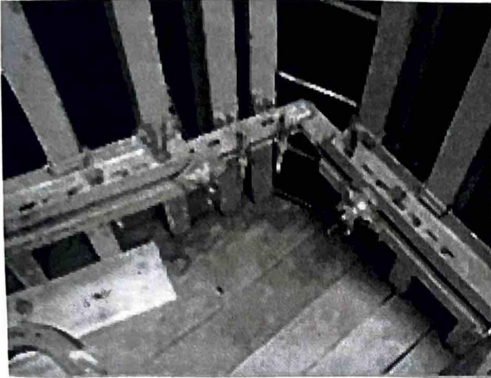
Fig.66 Elemente de soldarizare a cofrajelor
