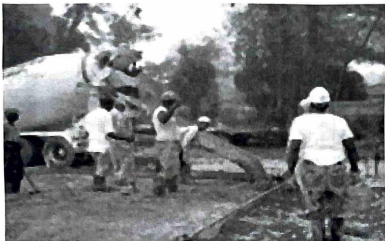
Fig.69 Punerea in opera a betonului pentru o cladire Industriala
