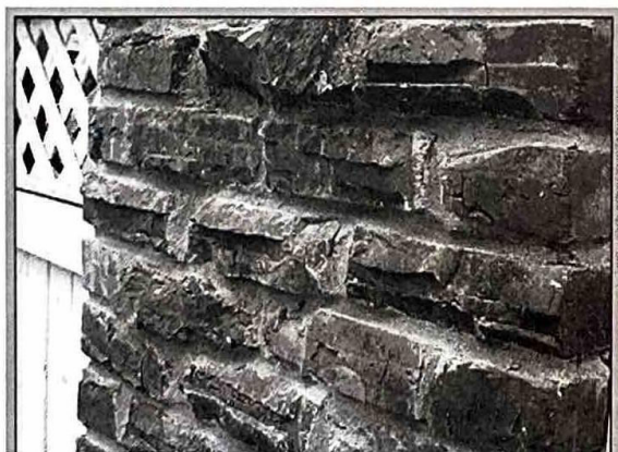
Fig. 15 Perete din zidărie, în stare bună
