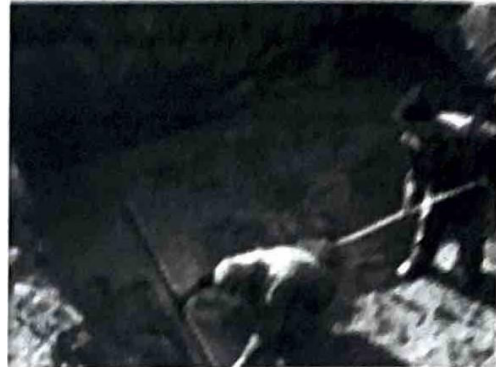
Fig.68 Compactarea betonului □1 nvelarea
