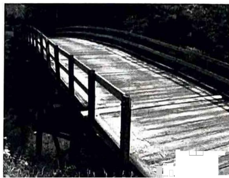
Fig. 12 Pod din lemn
