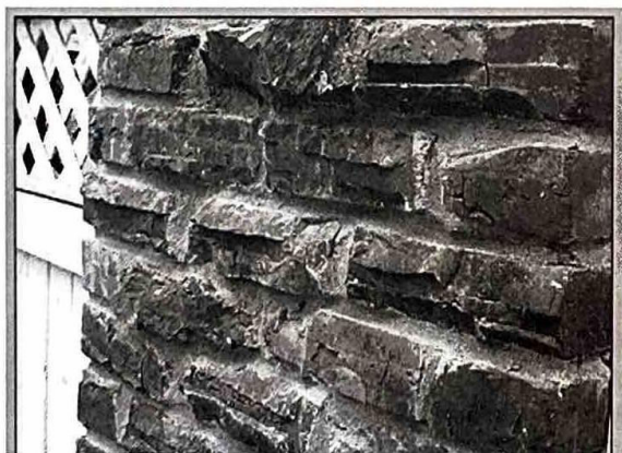
Fig. 15 Perete din zidărie, în stare bună
