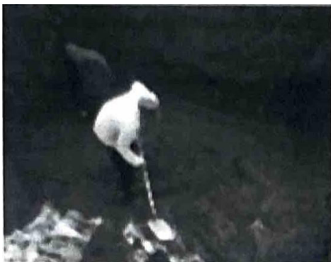
Fig.68 Compactarea betonului □1 ntvelarea
