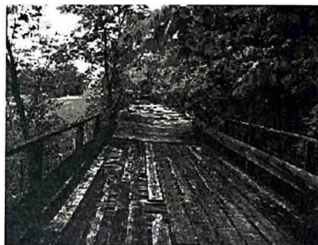
Fig. 14 Pod din lemn
