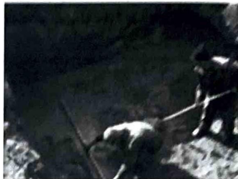
Fig.68 Compactarea betonului □1 ntvelarea
