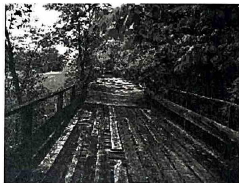
Fig.14 Pod din lemn
