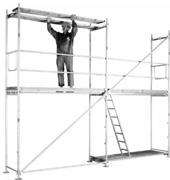
Fig. 43. Montarea primului nivel de schelă
