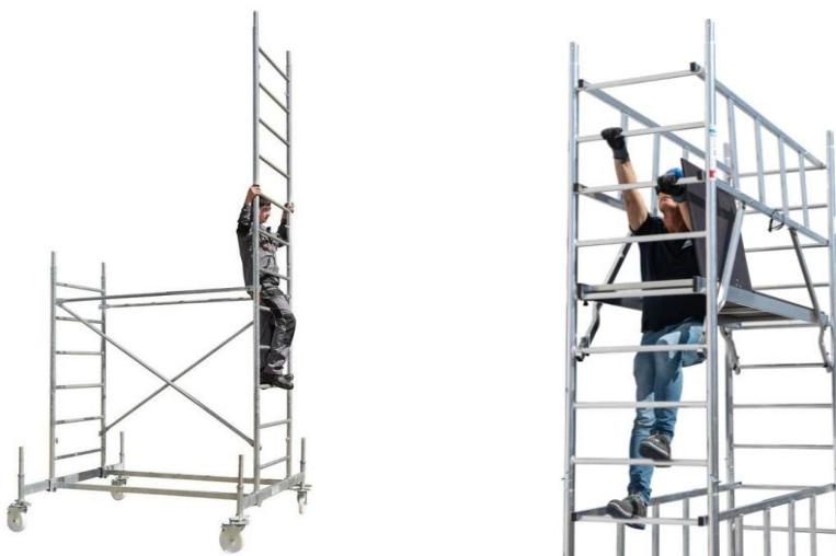
Fig. 48. Instalarea scărilor de acces
