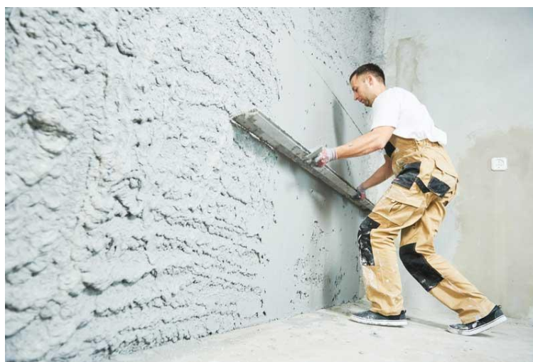
Fig. 29. Nivelarea stratului de grund cu dreptarul
