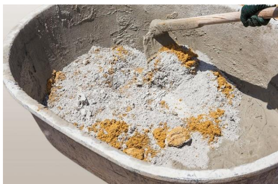
Fig. 16. Prepararea manuală a mortarului
