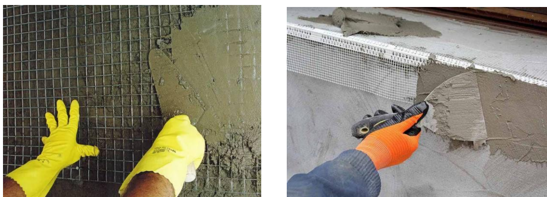
Fig. 47. Montarea plasei de armare pe suprafețe
