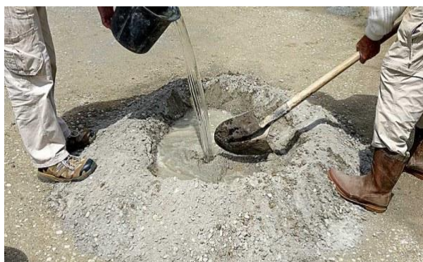
Fig. 16. Prepararea manuală a mortarului
