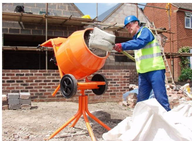
Fig. 17. Prepararea mortarului cu malaxorul
