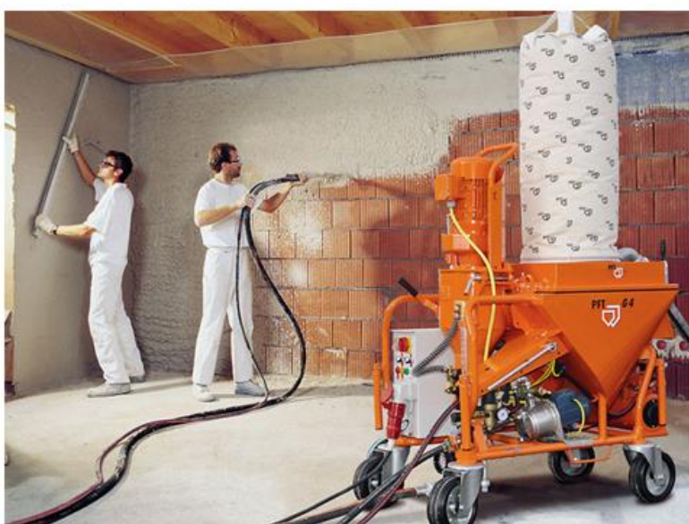
Fig. 60. Procesul de tencuire cu mașina de tencuit
