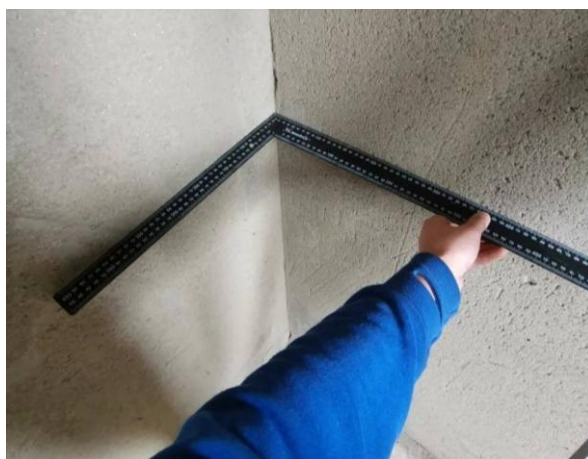
Fig. 32. Verificarea colțului interior de 90°
