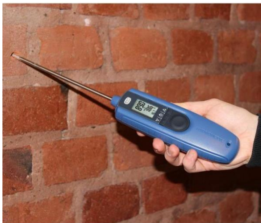
Fig. 19. Verificarea umidității suprafeței cu umidometrul
