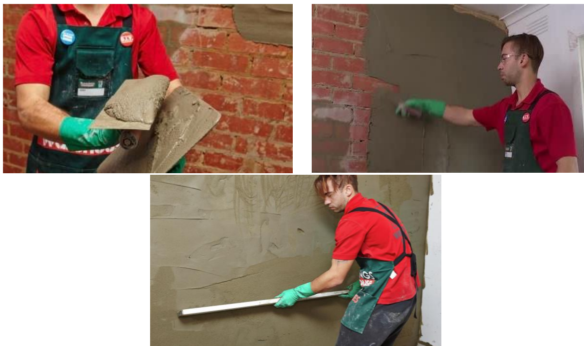
Fig. 51. Aplicarea mortarului prin întindere
