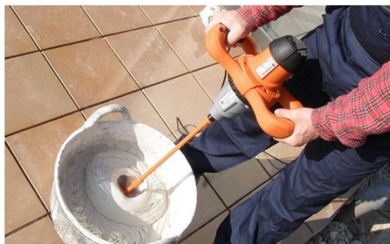
Fig. 44. Prepararea mortarului cu malaxorul
