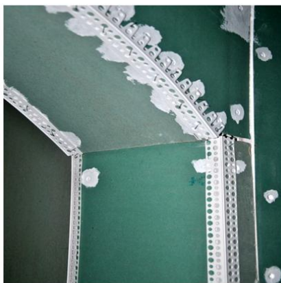
Fig. 49. Fixarea profilurilor de colț
