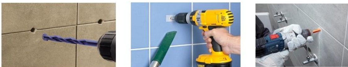
Fig. 14. Executarea găurilor cu burghiul
