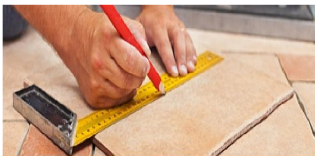
Fig. 8. Însemnarea plăcilor cu creionul și colțar de 90°
