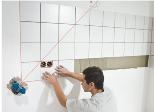
Fig. 17. Verificarea montării plăcilor cu nivela cu laser
