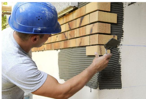
Fig. 42. Așezarea plăcilor de colț
