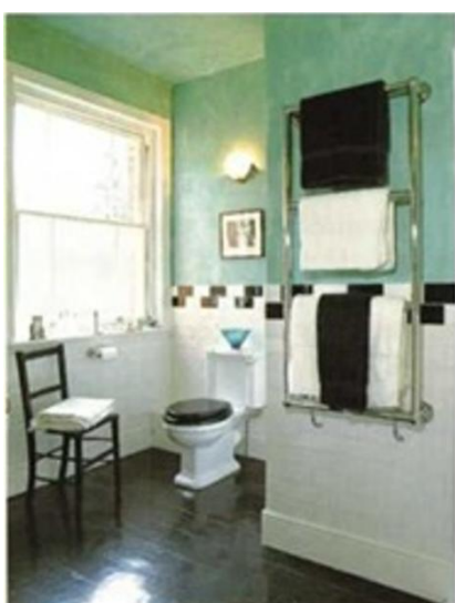
Fig. 25. Executarea frizelor din plăci de culoare diferită:
