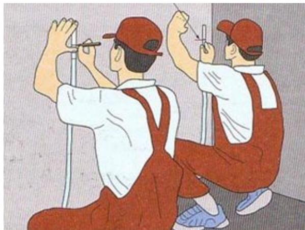
Fig. 18. Trasarea cu ajutorul furtunului de nivel
