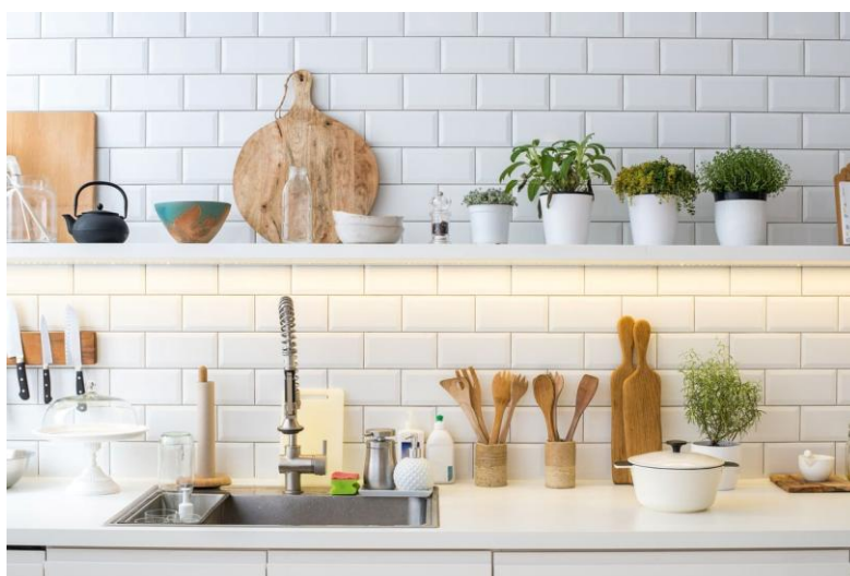
Fig. 22. Placare prin metoda de alternare
