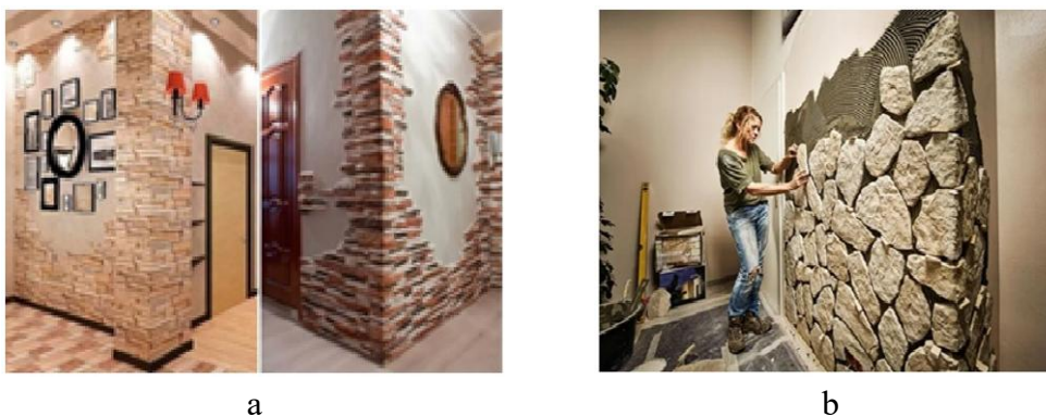
Fig. 39. Realizarea placării cu plăci 3D (în relief): a – montarea plăcilor fără rosturi; b – montarea cu rosturi
