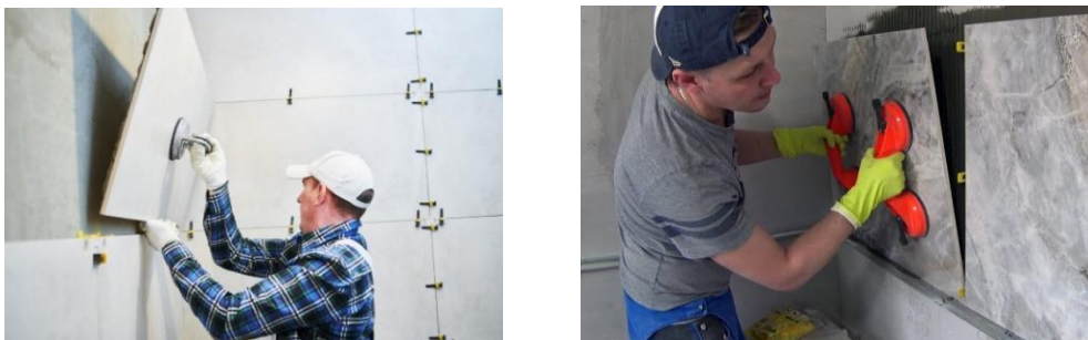
Fig. 36. Montarea plăcilor de dimensiuni mari
