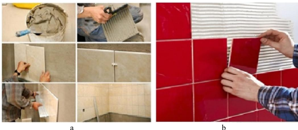
Fig. 21. Aplicarea adezivului: a – aplicare pe placă; b – aplicare pe perete
