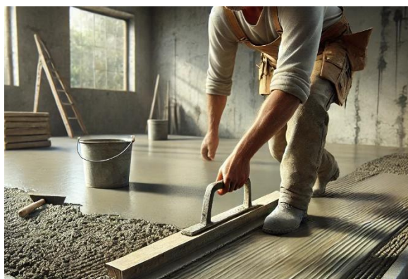
Fig. 37. Aplicarea și nivelarea șapei
