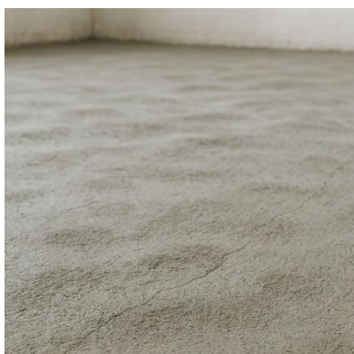
Fig. 50. Planeitate incorectă
