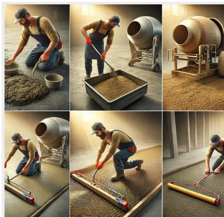
Fig. 38. Procesul de realizare a șapei din mortar semiumed
