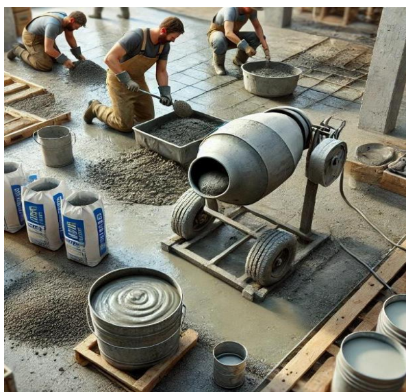
Fig. 24. Prepararea mecanizată a mortarului
