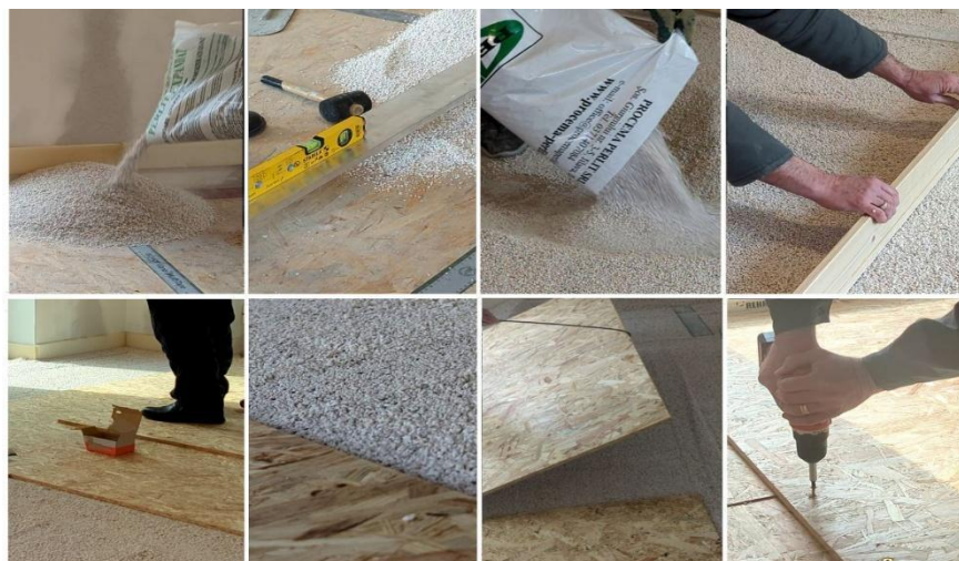
Fig. 45. Șapă uscată cu plăci din OSB (plăci din fibre orientate)
