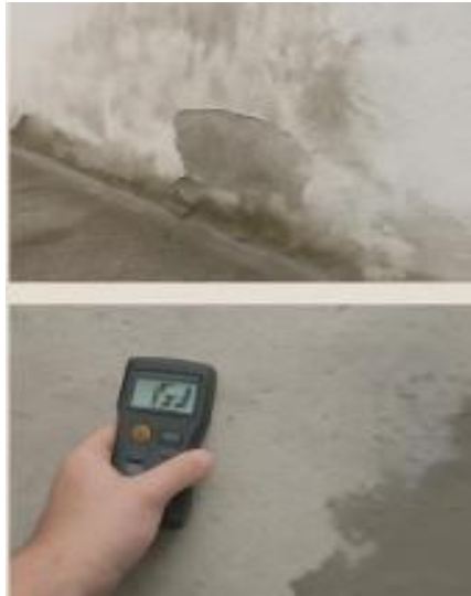
Fig. 28. Umiditate excesivă
