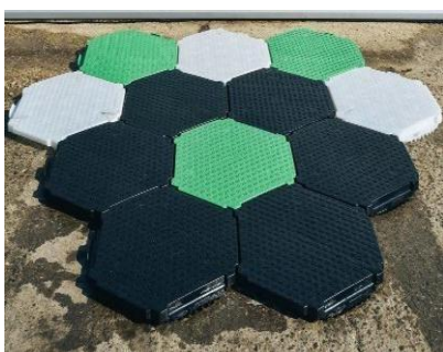
Fig. 38. Montarea plăcilor hexaedrice din centrul încăperii
