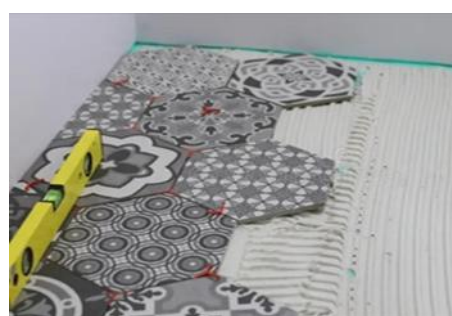
Fig. 39. Montarea plăcilor hexaedrice dintr-o zonă focală
