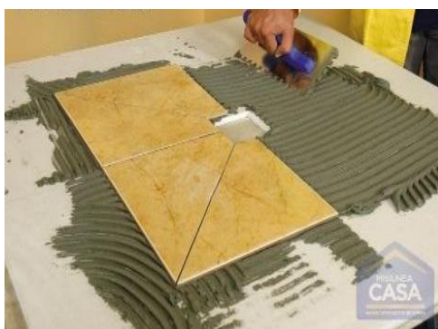
Fig. 46. Montarea pantei
