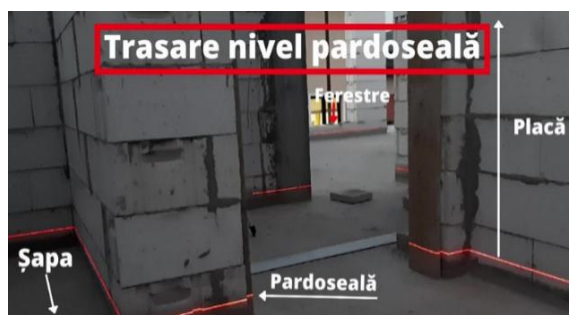
Fig. 34. Trasarea pardoselii cu nivela laser
