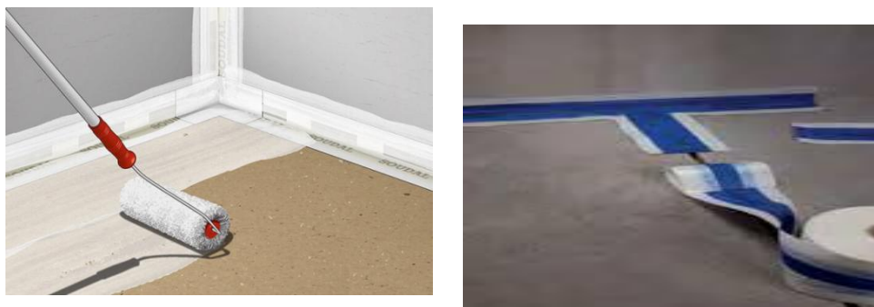
Fig. 30. Etanșarea colțurilor și a pardoselilor
