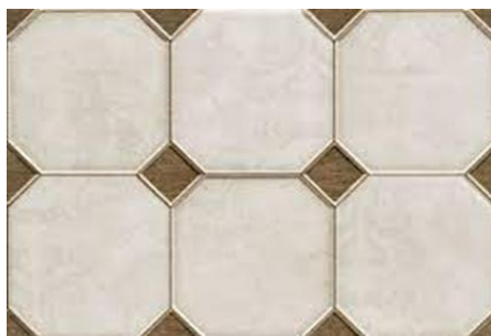
Fig. 40. Placarea cu plăci octaedrice
