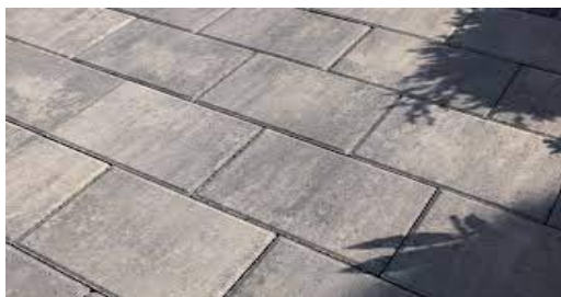
Fig. 47. Suprafață pavată cu plăci de beton
