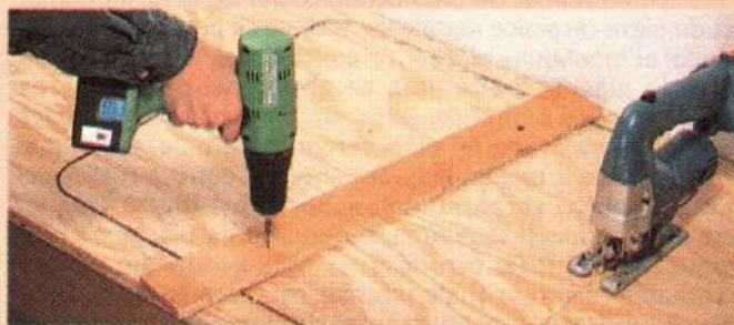
Fixarea provizorie a unei șipci împiedică căderea și ruperea nedorită a zonei de blat ce va fi decupată.
