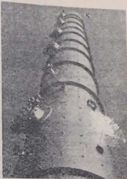
Fig. 5.24. Coloană asamblată din tronsoane.
