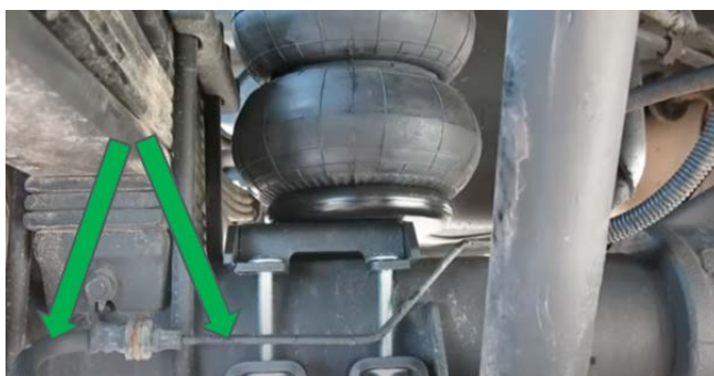
Fig. 19. Suspensie pneumatică a autocamionului (cu săgeți sunt indicate furtunul și conducta pneumatică)
